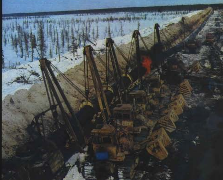
ТРАНШЕЯ ГАЗОПРОВОДА УХОДИТ НА БОЛЬШУЮ ЗЕМЛЮ.
