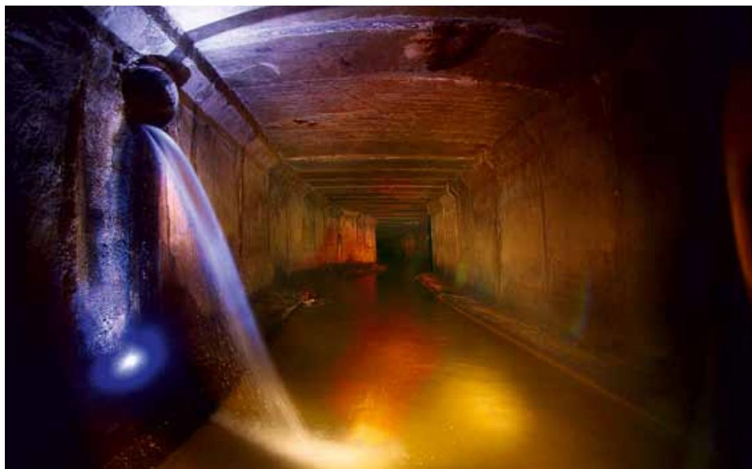
**Временный коллектор.** Для того чтобы отремонтировать коллектор, по которому течет река, надо сначала прорыть еще один, временный, чтобы можно было осушить основной и спокойно проводить в нем ремонтные работы.
