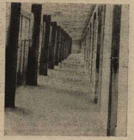
Дом сотрудников Ниромфина (архитектор Глеб Бурга) на Новинском бульваре. Образец архитектуры того конструктивизма: столбы вместо 1-го этажа, сплошные стальные ланты окон и т. д. Эти элементы в данной постройке носят характер чисто формальных приемов. Во внутренней планировке применен принцип «улицы внутри дома», — длинный «коридор», тянувшийся вдоль всего фронта дома
