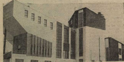
Клуб имени Русакова (союз коммунистиков), Москва. Выступающие наружу балки витрепного вида образуют форму своеобразного рупора. Этот внешний эффект не оправдан ни со стороны художественного замысла, ни со стороны внутренней планировки здания
