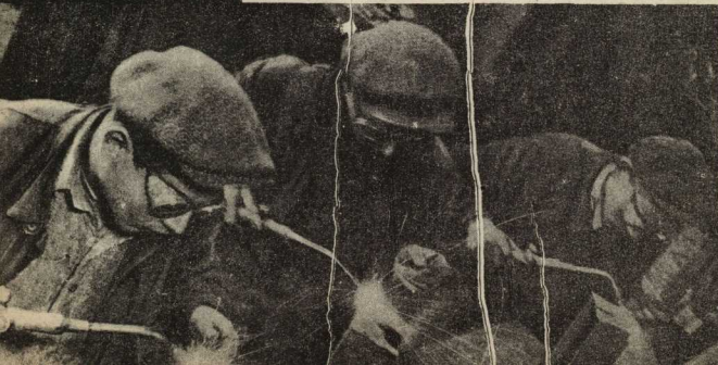
Комсомольская бригада свайщиков за работой в новом цехе завода «Динамо».
