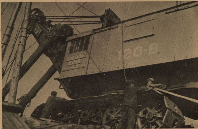
установка мощного экскаватора в 250 тонн на г. агач
