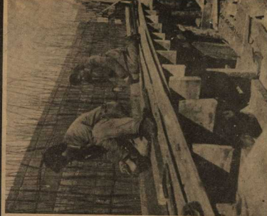
Визна арматуры на строительстве литейного цеха
