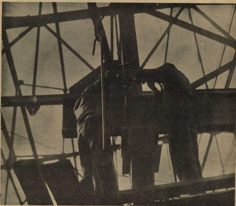
НАР. ПНЕВМАТИЧЕСКОЕ СВЕРЛЕНИЕ ТАВРОВЫХ БАЛОН
