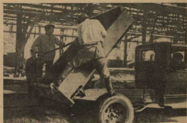
валянка бетоном полв резервного цеха
