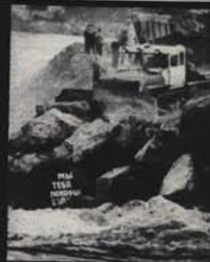
Наша обложка перекрытие Енисея.
