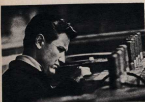
Монтаж энергоблока — это сотни сложнейших операций. В каждую из них люди вкладывают все свое мастерство и опыт.
