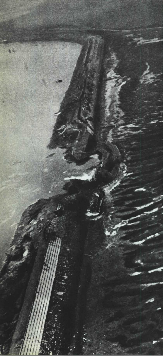
Англия. Вода пробрала брешь в плотине. Пришлось соорудить второй вал в виде дуги.
