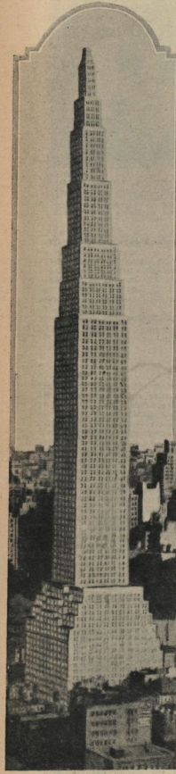
Стропщаяся в Нью-Йорке величайшая в мире дом Ларкин-Торур, предель достигшая американской строительной техники, в 110 этажей
