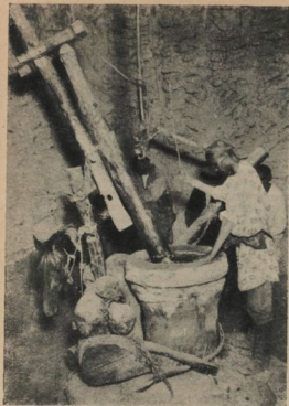
«Май-джин» — привитая масличная для выделения масла на хлопчатых или хлопчатобумажных, применяемая в Узбекистане.
