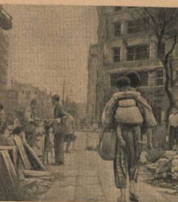
В разрушенных кварталах.
