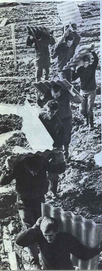
Первый дождь выведен под крышу.
