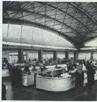
по сравнению с самыми совершенными плоскостными сооружениями конструкция сферо-оболочки дает экономия до 50 процентов стали и до 40 процентов бетона. Здания с такими перекрытиями строятся также в Челябинске и в других городах.
