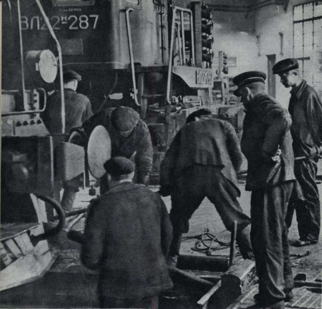
Несколько минут назад в цех подали неисправный электровоз. И тутчас бригада приступила к ремонту.
