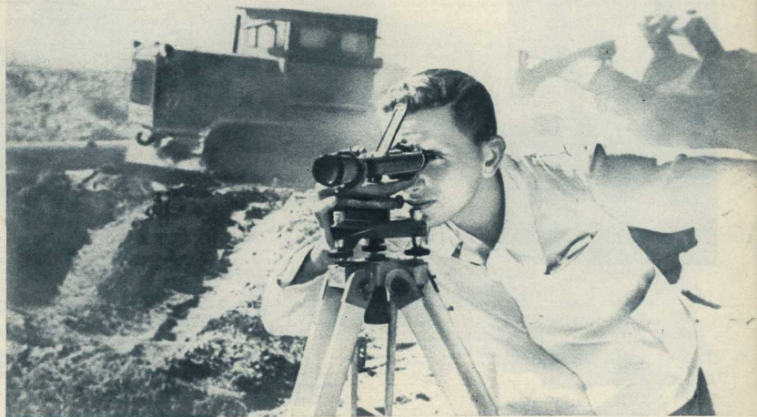
Старший прораб Александр Романов с помощью нивелира определяет высотные отметки дамбы в районе обводного соединительного канала.
