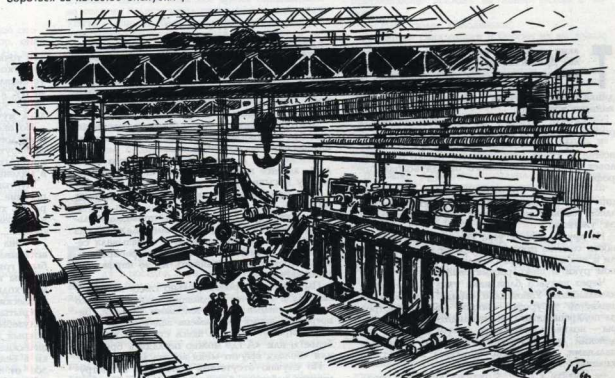
МОНТАЖ ЧИСТОВЫХ ПЛЕТЕЙ НА СТАНЕ «2500».
