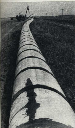
Через несколько минут еще одна секция нефтепровода ляжет на дно траншеи.
