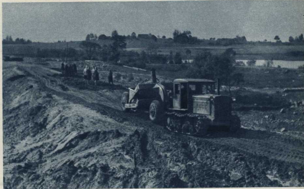
Скрепер на участке будущей земляной плотины.
