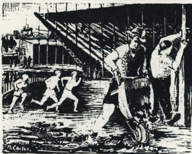
Еще не все строительные работы закончены на Олимпийском стадионе, а мельбурихские спринтеры уже тренируются.
