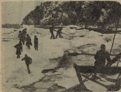
В таком льду «Сибирьков» продвигается «перетягивая» — подтягиваясь от льдины к льдине на стальных тросках
