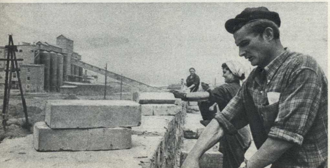
С каждым днем растут стены арматурной мастерской. Сегодня кладку ведет сам бригадир — Геннадий Турев.
