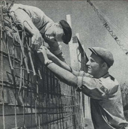
Комсомольцы Альберт Кондрашин (слева) и Анатолий Миловидов устанавливают арматуру. Когда подсузет бетон, все уже будет готово.
