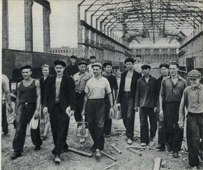
Будущий цех электрелиза... А это его строители — комплексная бригада Николая Варфоломеева. (Бригадир — третий слева.)
