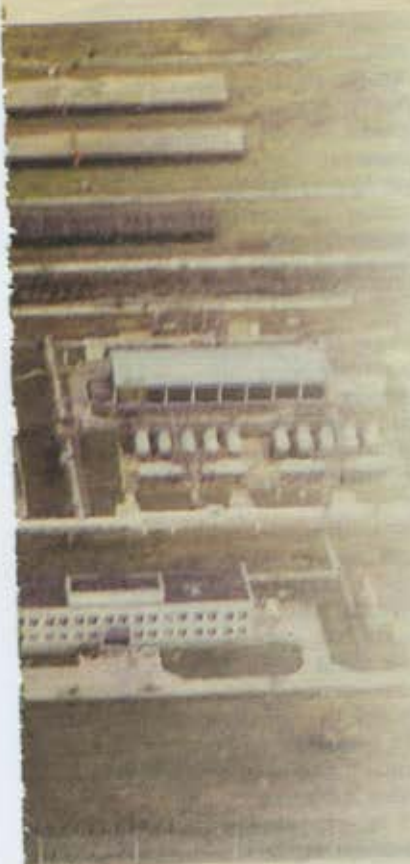
Объект в г. Чаплевасне.
