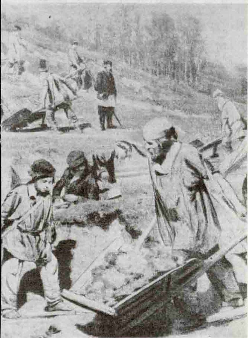
К. САВИЦКИЙ. Ремонтные работы на железной дороге (фрагмент).
