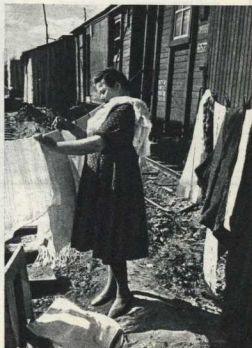
А на переднем крае стройки пока еще мнут «на колесках».
