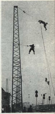
Завершается электрификация железнодорожной магистрали Москва — Омск — Новосибирск. На снимке: рабочие электромонтажного поезда № 706 монтируют контактную сеть на станции Володино, Томской железной дороги.
