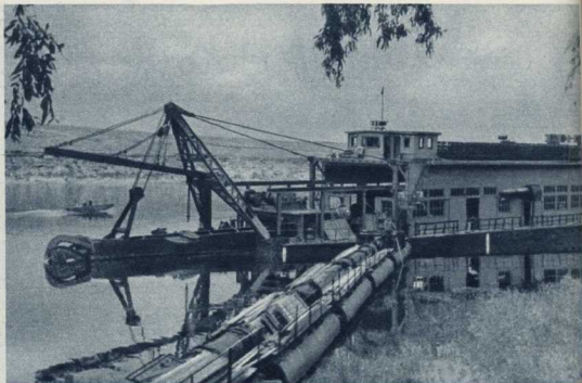
Строительство Каховского гидроузла. Сверхмощный земснаряд «1000-80». Фото Ю. Лихутин
