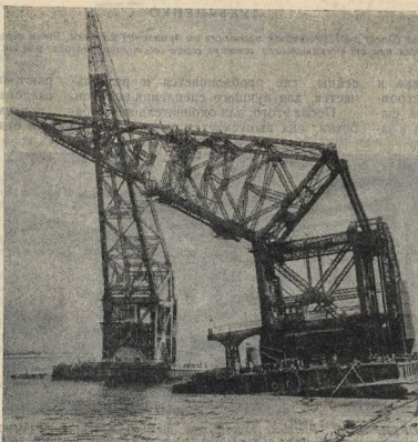
ВВЕРХУ: Тип мощного пловучего крана: на рисунке изображен момент сооружения 350-тонного пловучего крана. Период краном особенно тяжело занять строение крана и с тем же в положении, нужное для скелета. НИЗУ: Схема работы крана.
