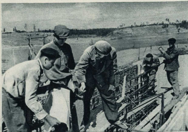
Комсомольско-молодежная бригада Вадима Соколова устанавливает арматуру на консоле верхнего бьефа. Члены этой бригады работают на стройке с самых первых дней.
