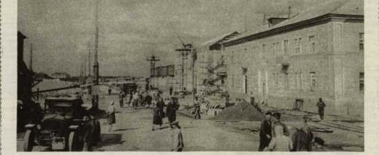
Строительство жилых домов на станции Люблино.
