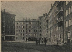
Лицевой фасад нового дома.
