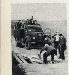
По пути пришлось починить мост.
