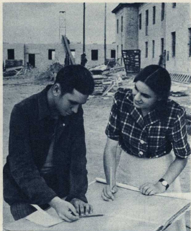
Сталинградгидрострой. На снимке: комсомолцы Владимир Жутов и техник строительного участка Вера Рошню.
