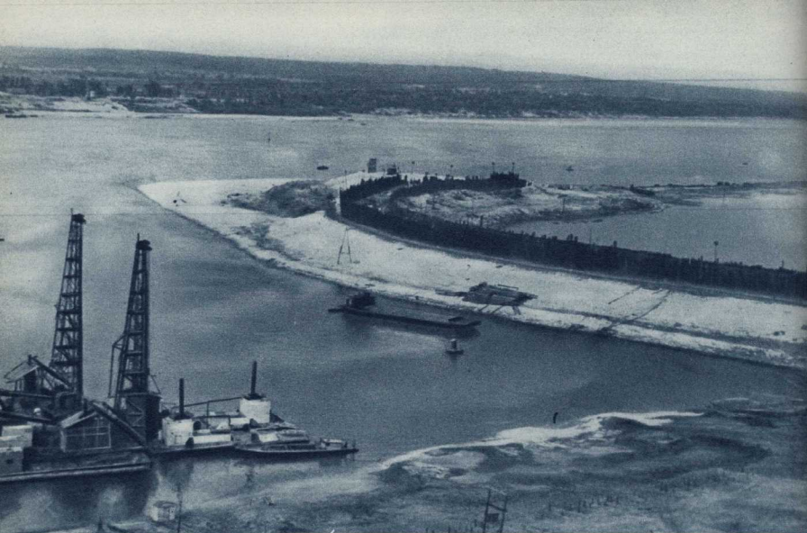
Общий вид строительства Куйбышевской ГЭС на правом берегу Волги.
