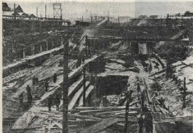
ВОЛХОВСТРОЙ: работы по выемке земли на котловине силовой станции.
