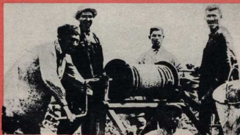
1912 год — строится нефтяной колодезь.
