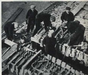
Заливаются бетоном последние арматурные бетонные арки.
