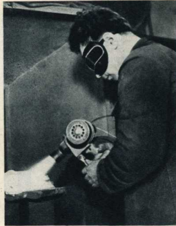
...Александр Васильевич Санников выключает ток, и из электрометаллизатора вихрем вырываются искры.
