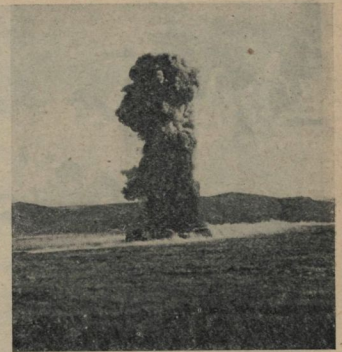
Туркиб пробивает себе путь. На фото—варьи сального грунта для производства выемки под полотно.
