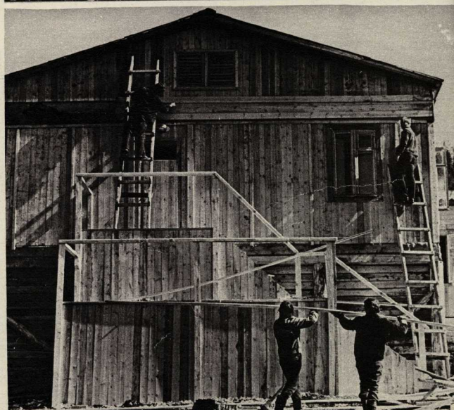
ЭТО ТОЖЕ УДИВИТЕЛЬНЫЙ ОБЪЕКТ. СТРОИТЕЛЬСТВО ПОСЛЕДНЕГО «ЗВЕЗДНОГО».
