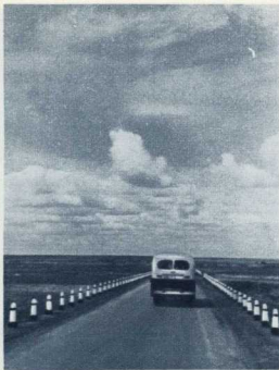
Вдоль канала проложено шоссе.
