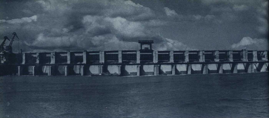
Общий вид водосливной плотины Цимлянского гидроузла.
