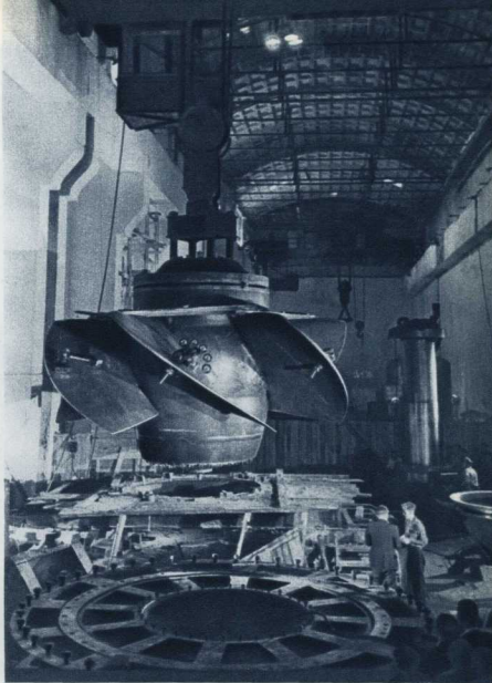
В машинном зале Цимлянской гидростанции.
