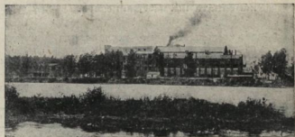
Электростанция им. Классона на торфу в Богородском уезде, Моск. губ.
