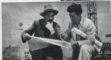
← Пользуюсь возможностью прямо на строительной площадке! Инженер О. Кузнецов и бригадир А. Яворский развернули чертёж, и начался горячий творческий спор.
