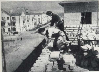
В прошлом году Борис Копай и Михаил Антипенко закончили курсы каменщиков, а сейчас их считают уже опытными строителями... Пройдет немного времени, и в 18-квартирный дом, возведенный их руками, въедут первые новоселы.
