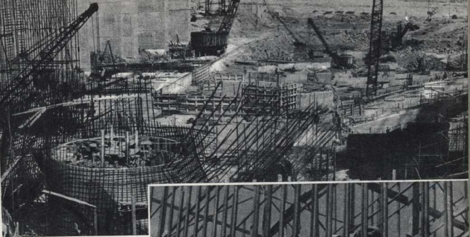
Тан выглядит строительная площадка будущей ГЭС.
