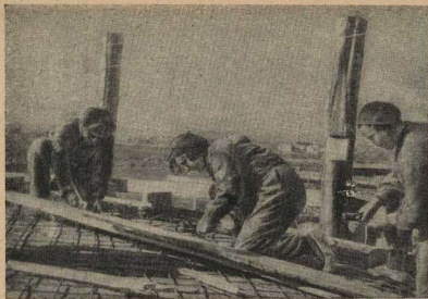
Новый город Комсомольск — дело рук комсомольцев. На снимке: удярная бригада арматурщиков.
