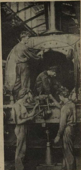
Бригада комсомольцев-ударников транспорта ремонтирует паровоз
