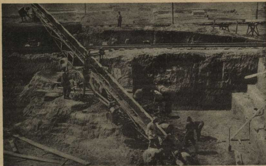
Бригада комсомольцев в котловане у транспортера
