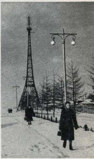
Эту телевизионную башню монтировала и поднимала комсомольско-молодежная бригада магаданских строителей.
