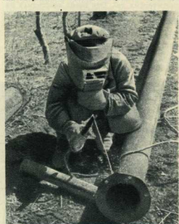
Для искусственного орошения прокладываются трубопроводы.
