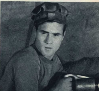
Бригадир проходчиков Михаил Комаров работа на строительстве московских станций «Новослободская» и «Комсомольская-кольцевая». Когда была окончена проходка, он приехал на Волго-Дон и выработывает свою «общинную» норму — 200 процентов (фото 2).
