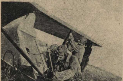
Сборка планиера требует особой тщательности и внимания. Плохо укреплённый водос, непослушный руль могут стоить жизни пилоту.
