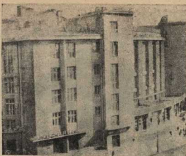
Главный фасад Дома культуры
