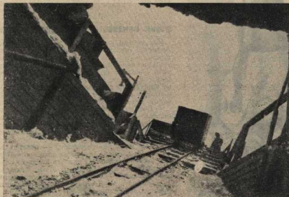
Шахты строящегося в Москве метрополитена с каждым днем все глубже уходят в землю
