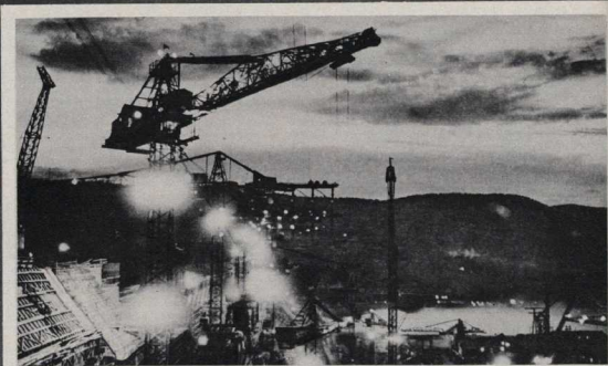
Всего вклад комсомола в сооружение энергетического гиганта — Красноярской ГЭС.
