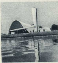
Это странное сооружение—церковь, построенная по проекту американского архитектора.
