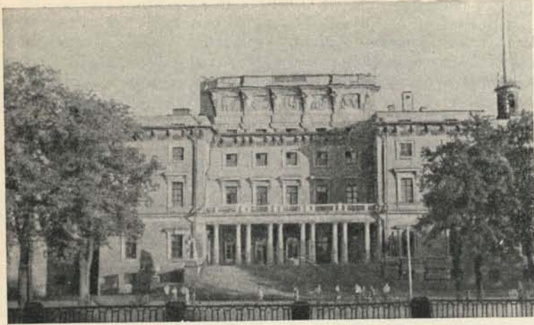
Инженерный замок—одно из стариннейших зданий Ленинграда. Здесь в 1918 году формировался первый комсомольский отряд, участвовавший в боях с немецкими интервентами.
